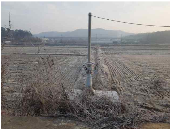
권양기 상태 양호
